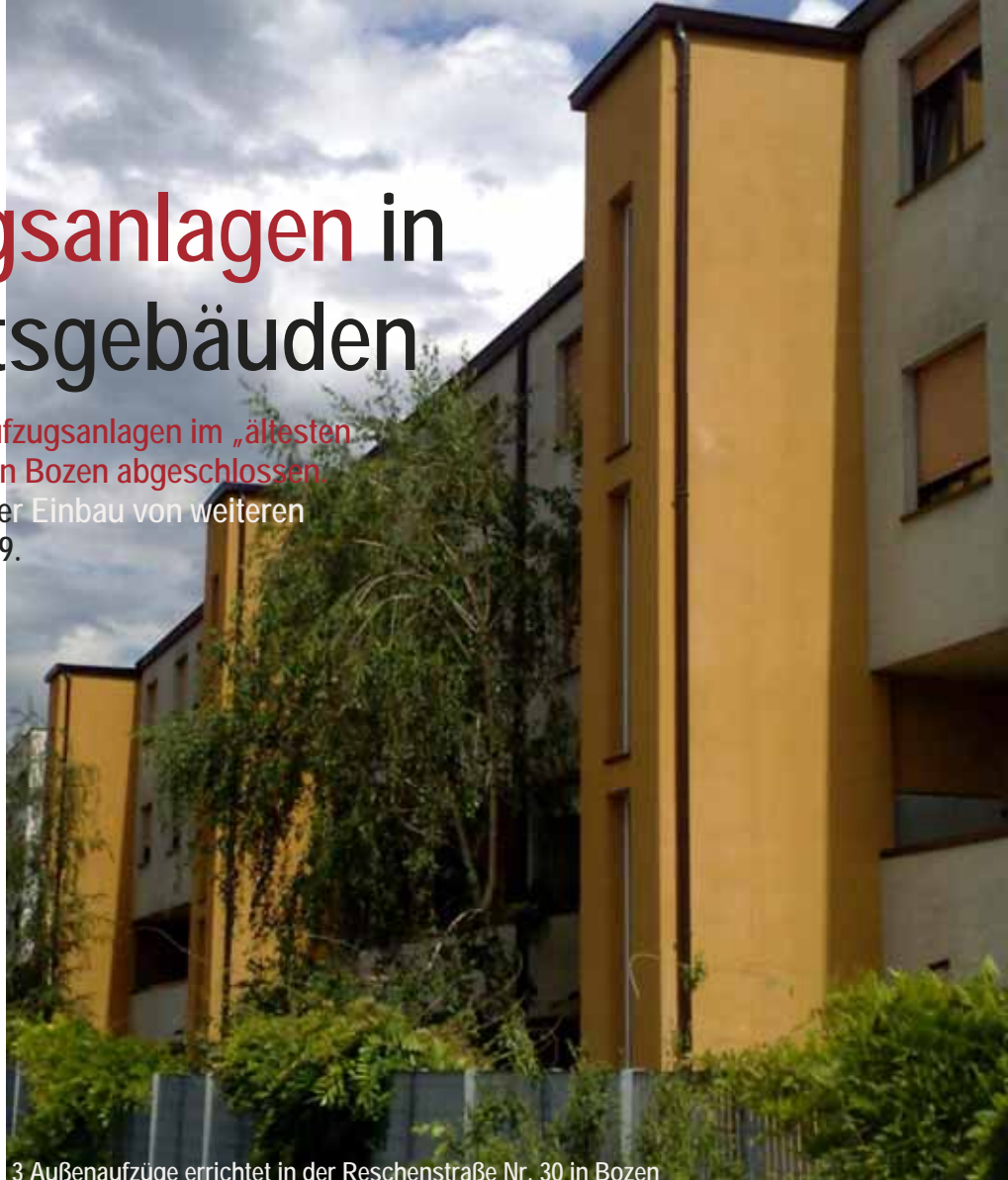
3 Außenaufzüge errichtet in der Reschenstraße Nr. 30 in Bozen
