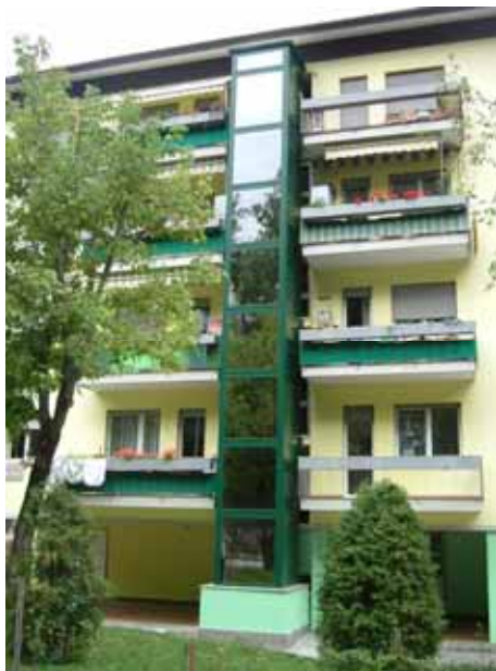
Beispiel einer nachträglich eingebauten Aufzugsanlage
