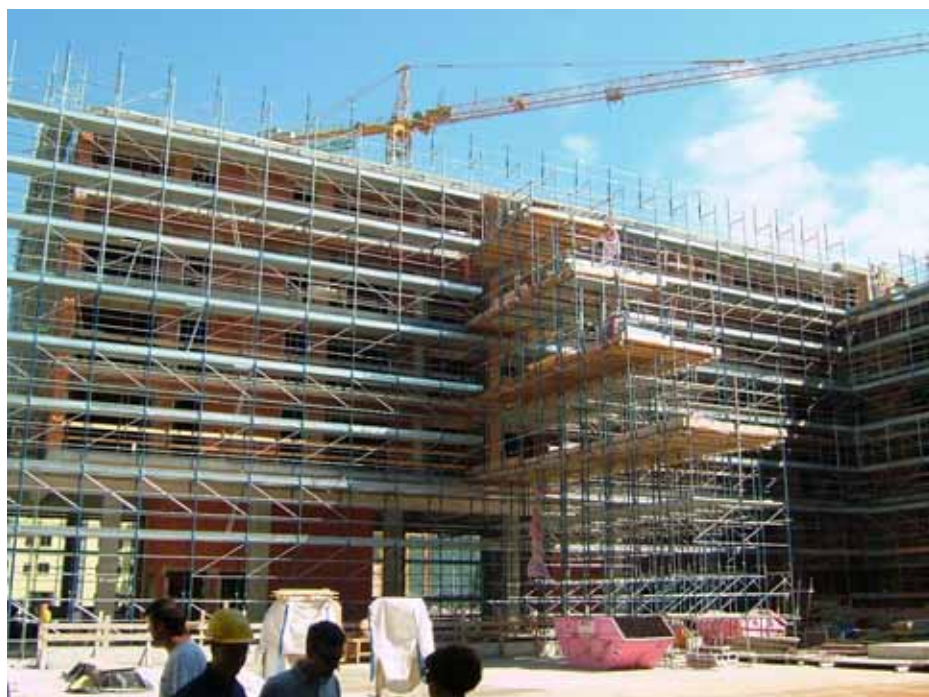
Gebäude in Bozen, Mozartstraße während der Bauphase.
