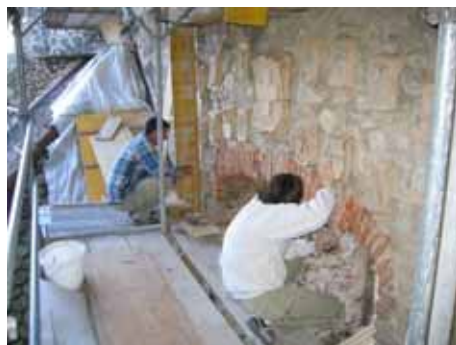
Arbeiter bei Sanierungsarbeiten
