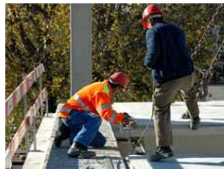
Arbeiter bei Instandhaltungsarbeiten
