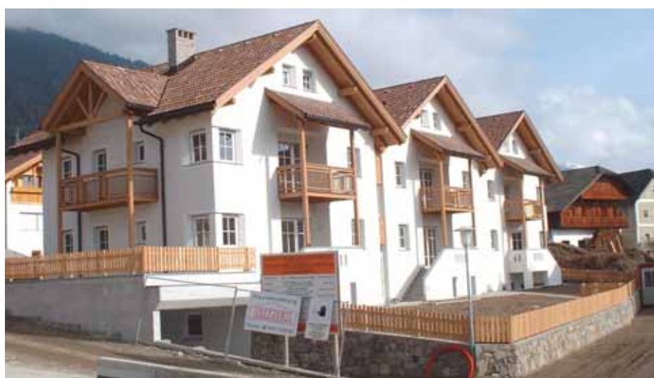
Gebäude des Wohnbauinstitutes in Pfalzen, Schulweg 1-2 bei der Fertigstellung
