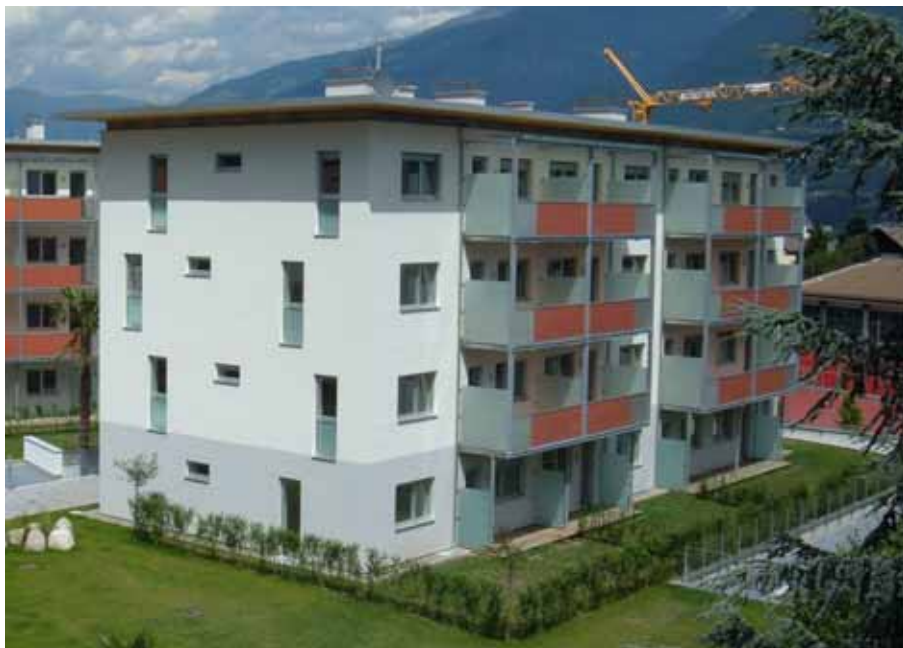
Ansicht eines der zwei neu errichteten Gebäude im Hofmann Areal in Lana.
