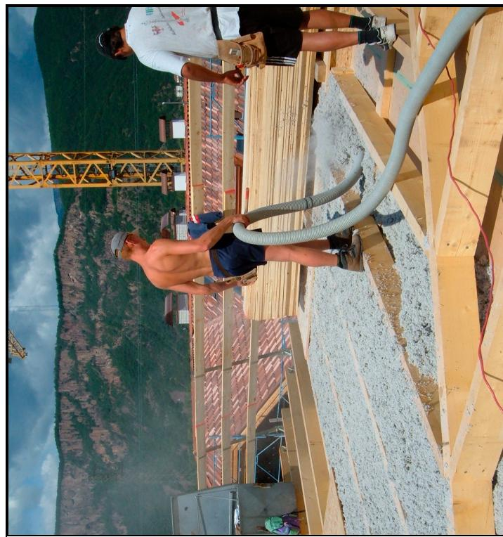
**Fig. 49: Befüllung mit Zelluloseflocken/
