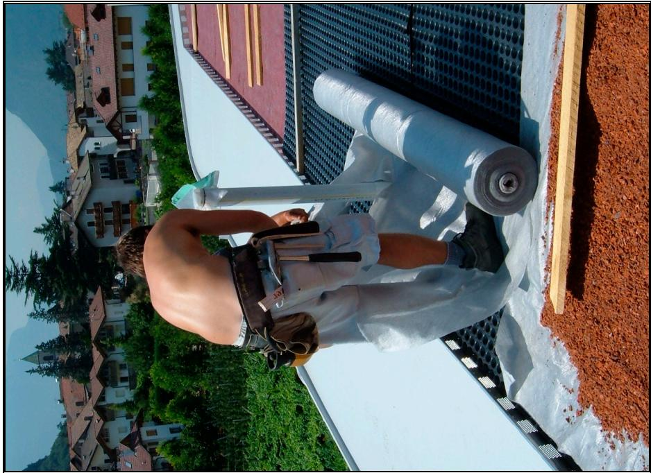
Fig. 44: Verlegung der Drainageschicht /
